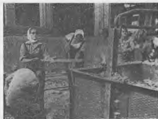
Студенты на строительстве цеха ДСК.
