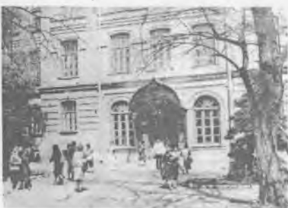
Корпуса института по улице Мира.
